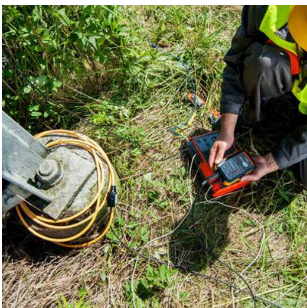
Figura 149. Verificación de la ausencia de tensión (Técnica, s.f.)
